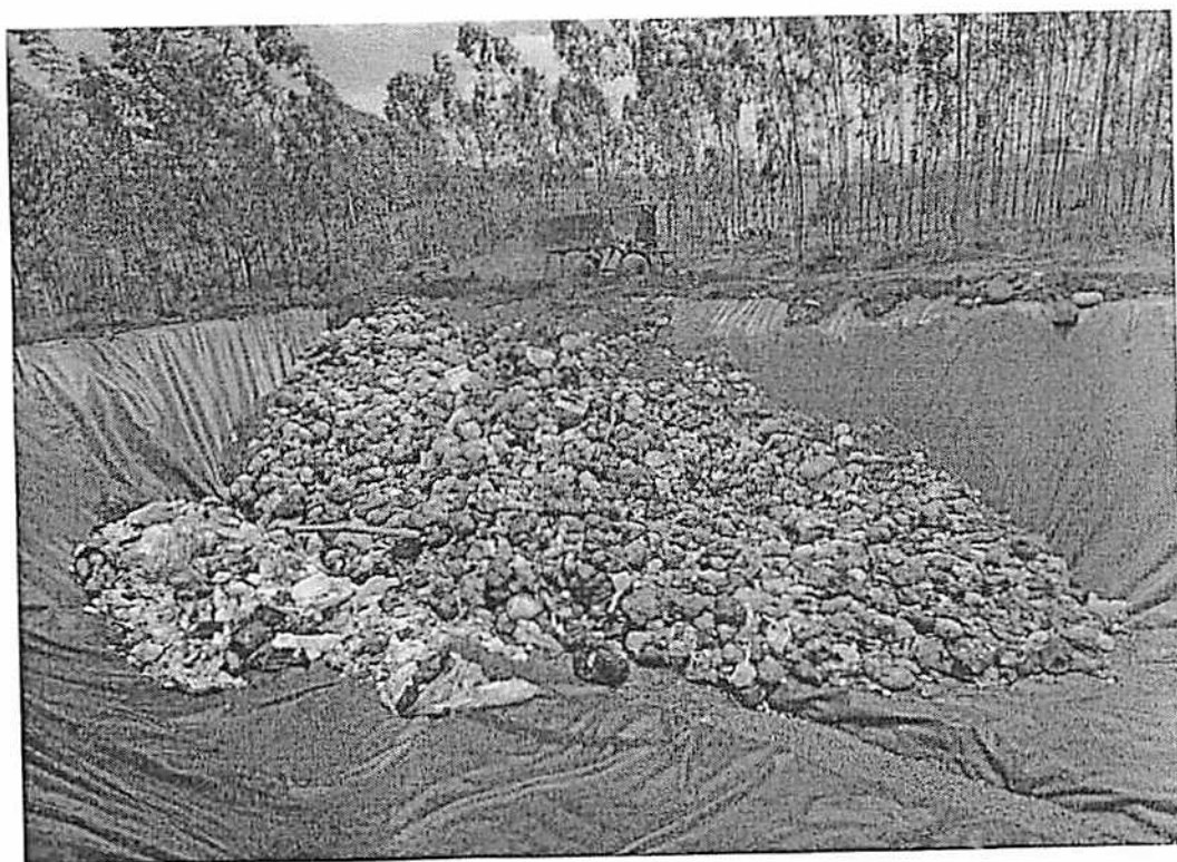
vala do aterro sanitário do município
